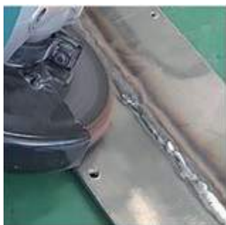
Limpieza en cordones de soldadura
